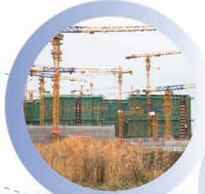
康桥市场租赁房正在建设
